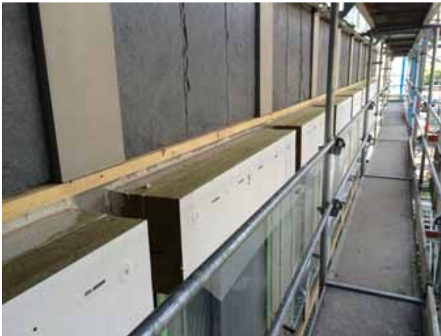
Abb. 5: Solche Jalousienkästen aus nicht brennbarer Steinwolle sind WDVS-konform und können sicher angeschlossen werden.
