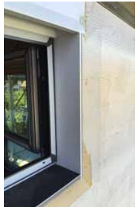
Abb. 6: Das WDVS-konforme Fensterkomplettsystem besteht aus einem Systemfenster mit integrierten Laibungsplatten, Fensterbankkeil und Jalousien- oder Rollladenkästen.
