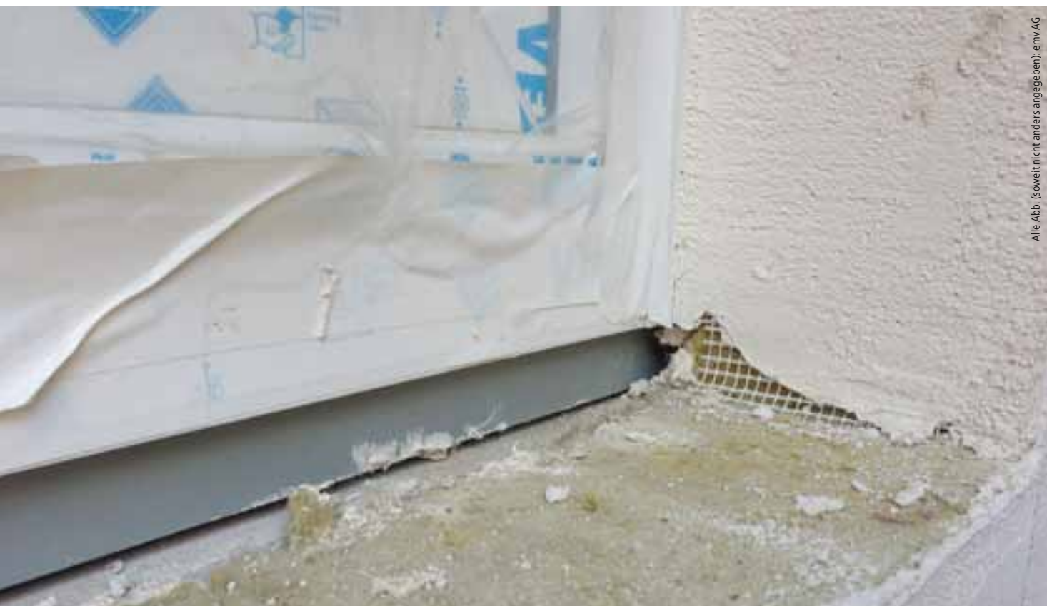
Abb. 1: An diesem Fenster wurde die graue Transportleiste nicht entfernt, was leider nur in seltenen Fällen passiert. Das Gewerke Loch im Anschluss an das WDVS ist deutlich sichtbar. Der Einbau einer zweiten Dichtebene ist durch die zu geringe Höhe nicht mehr möglich.
